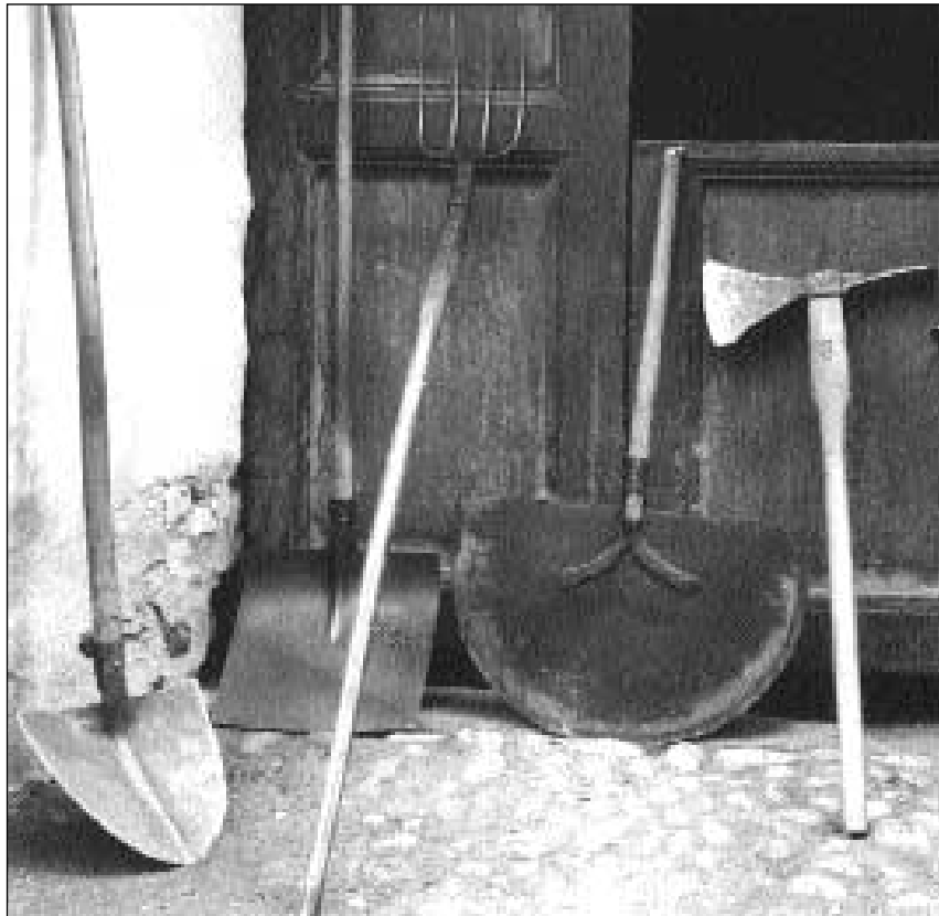
(Da sanestra) badigl – pala da naiv – furtga da grascha – pala da sauar, che vegn chatschad'en per travers dal dutg, per tegnair si l'aua – zappa d'uals u zappa da far dutgs; La part ch'è sco ina sigir serva per tagliar il tschispet (Zernez 1921).
