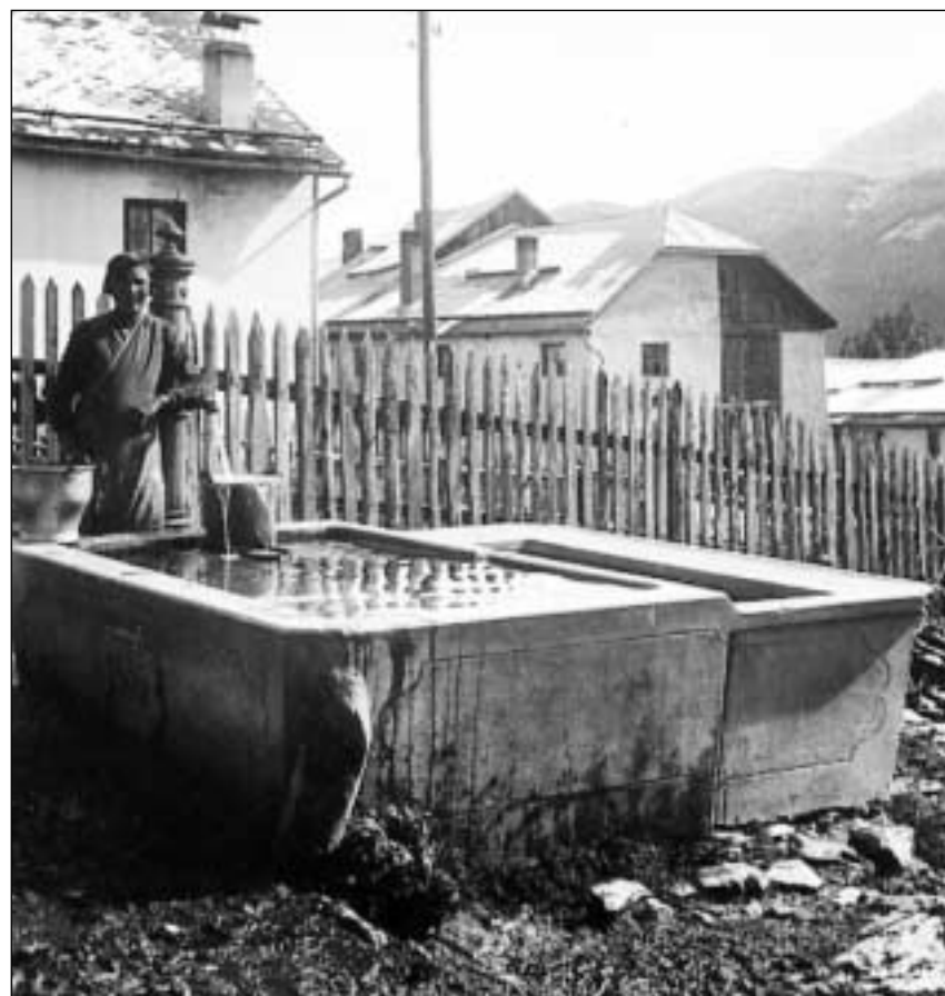
Bigl da cement a Tschlin, cun la tipica partiziun en dus: il bigl grond sura per bavrar e quel pitschen, pli bass giu, per lavar.
