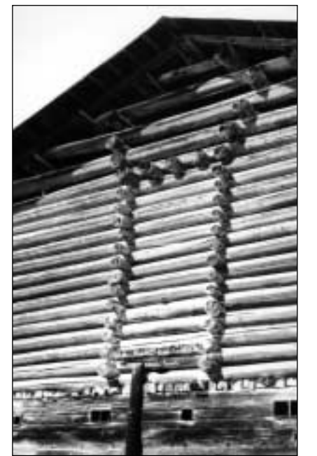
Lattida da dadora: sut la culmaina vesaina las testas dad indesch lains radunds che furman ina mesa glina culs pizs ensi. Las dus lingias verticalas separan ils ladretschs da l'iral. Giusum, cun lains quaders e fanestrettas, è la stalla (Fidaz 1999).
