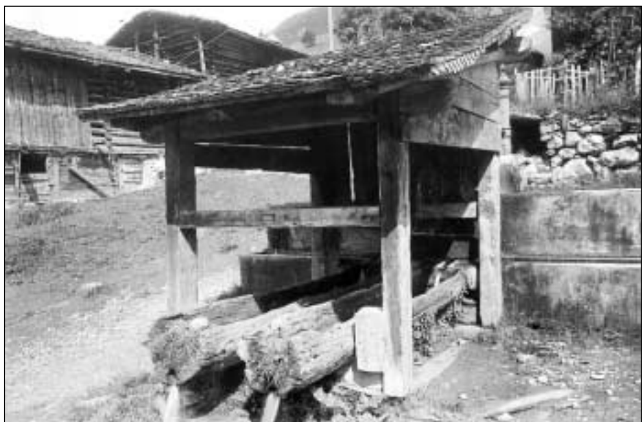
Bigl cuvert a Sumvitg. Ins vesa in toc dal bigl sura per bavrar, da cement; quel sut per lavar è fatg mo or da dus gronds lains chavad's or. El nun ha nagin stapun, uschia che l'aua curra libramai vinavant.
