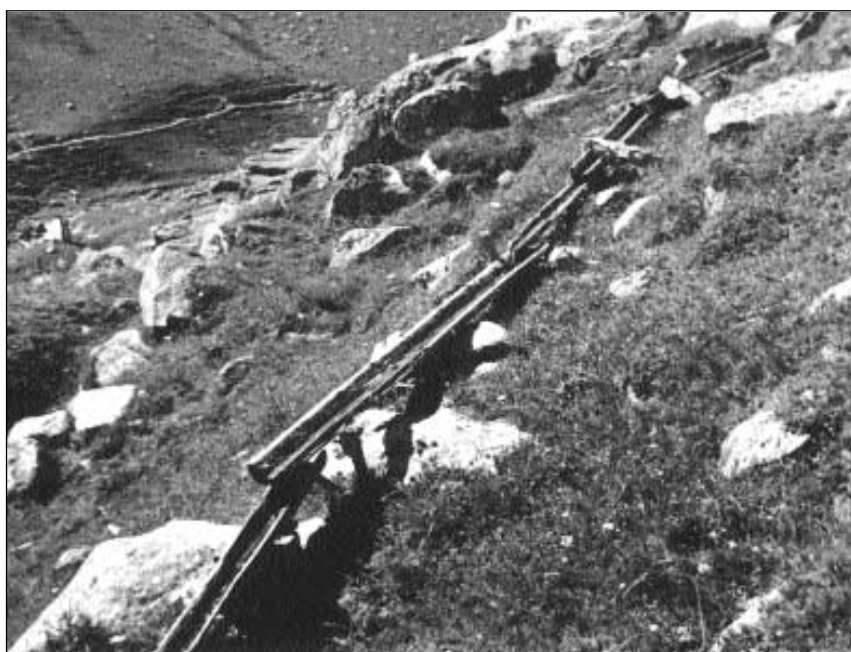
Chanals da lain mo ina sur tschella, gnanc liadas tranter pèr (Valtgeva, Tujetsch).
